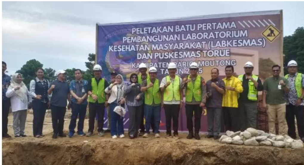
Gambar 3.7 Pembangunan Puskesmas Torue dan Labkesmas
